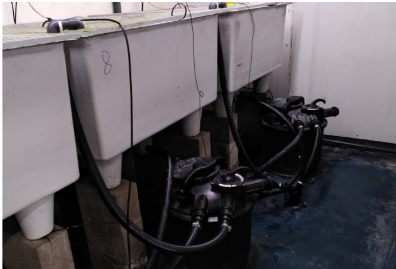
Figuur 2: Individuele tankopstelling met eigen biofilter
