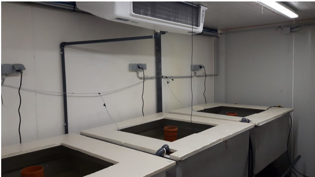
Figuur 1: Binnenzicht van een koelcel
