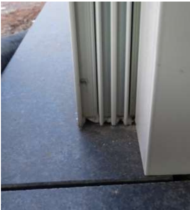
Figuur 17. Raamkader staat quasi volledig op blauwe hardsteen dorpel.
