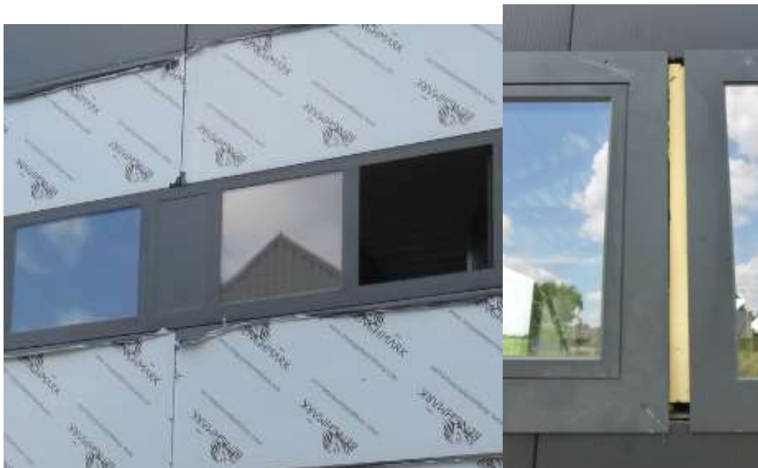
Figuur 92. Buitenzicht "in het vlak". Let op de ontwateringsgaatjes rechts.
