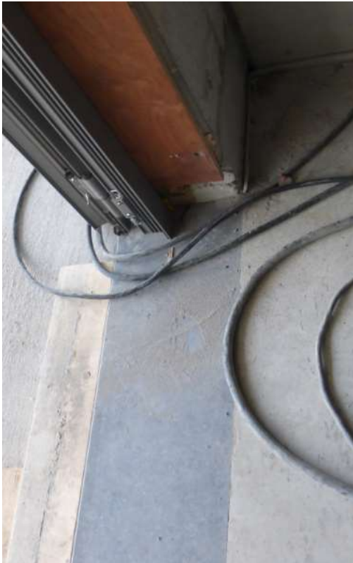
Figuur 22. Aansluiting dorpel op binnenwand en betonvloer.
