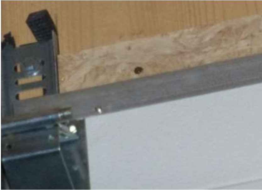
Figuur 33. Compressiebanden en extra uitdikking van de wand.
