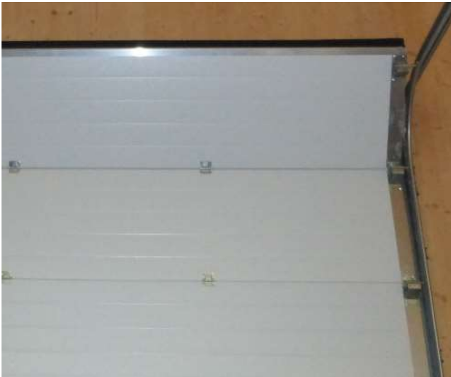
Figuur 26. Stalen kader met sandwichelementen van het poortblad.
