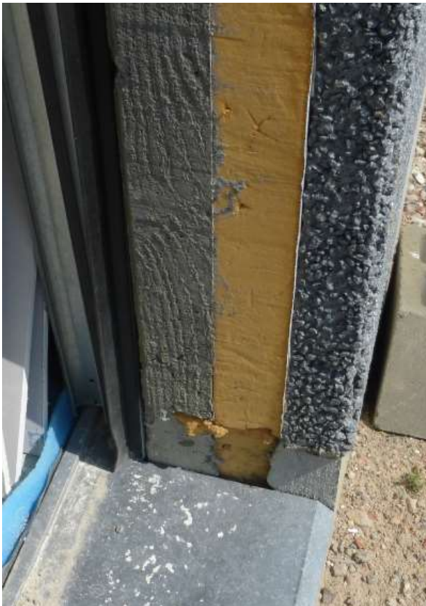
Figuur 65. Dagkant waarop isolatiestrook en profiel kunnen worden gemonteerd.
