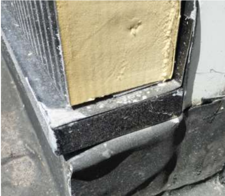
Figuur 77. Startprofiel overbrugt isolerend sandwichpaneel.
