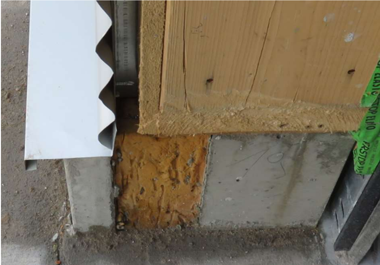
Figuur 105. Aansluitingsdetail met geïsoleerd sandwichpaneel.
