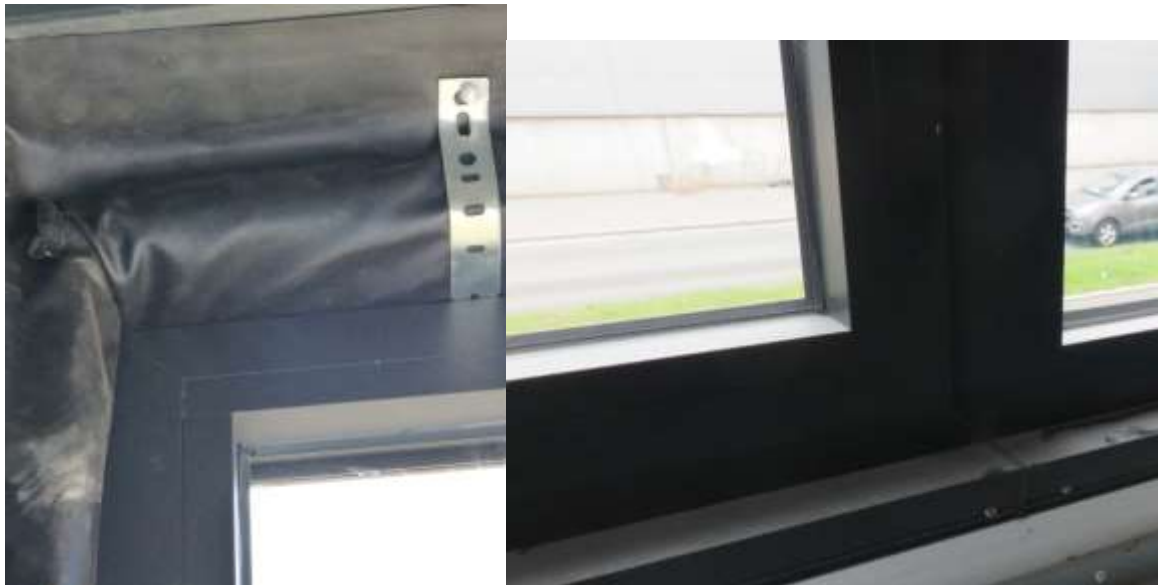
Figuur 91. Bevestiging met raamanker en EPDM. Afwerking langs binnen met alu profiel.
