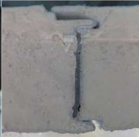
Figuur 73. Goed aaneengesloten plaatsing versus slechte aansluiting tussen twee panelen.
