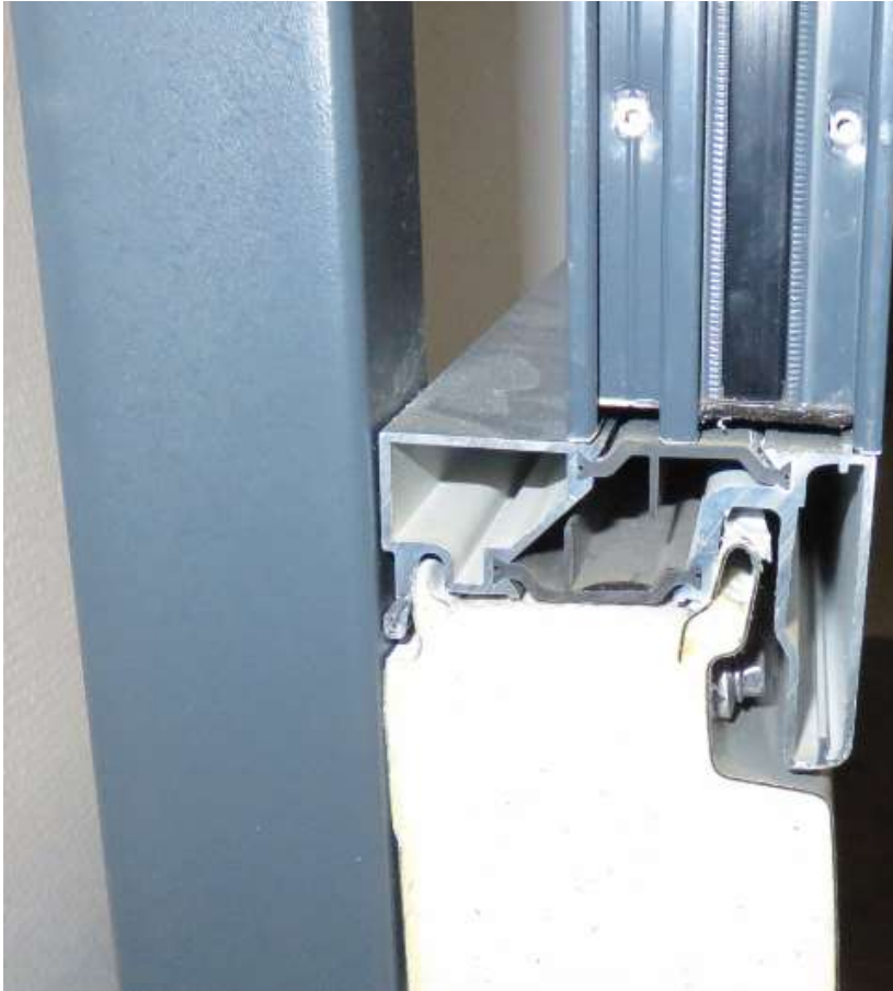
Figuur 93. Verticale doorsnede: adapter op onderzijde raam bevestigd. 35
