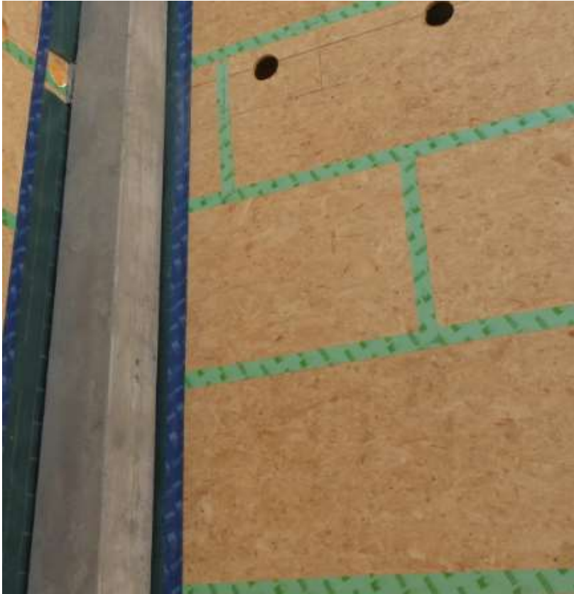
Figuur 103. Luchtdichting dankzij tapes en folie.
