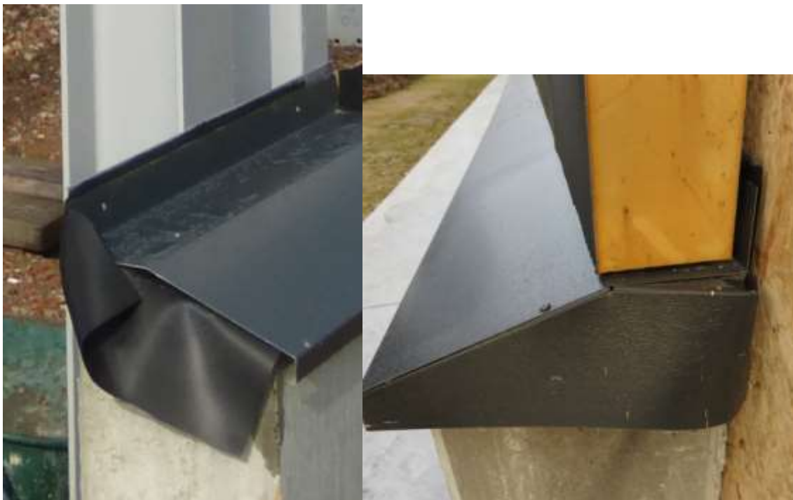
Figuur 76. Startprofiel loopt door en betonblad is dikker dan staal sandwichpaneel.
