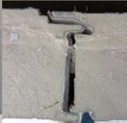
Figuur 73. Goed aaneengesloten plaatsing versus slechte aansluiting tussen twee panelen.
