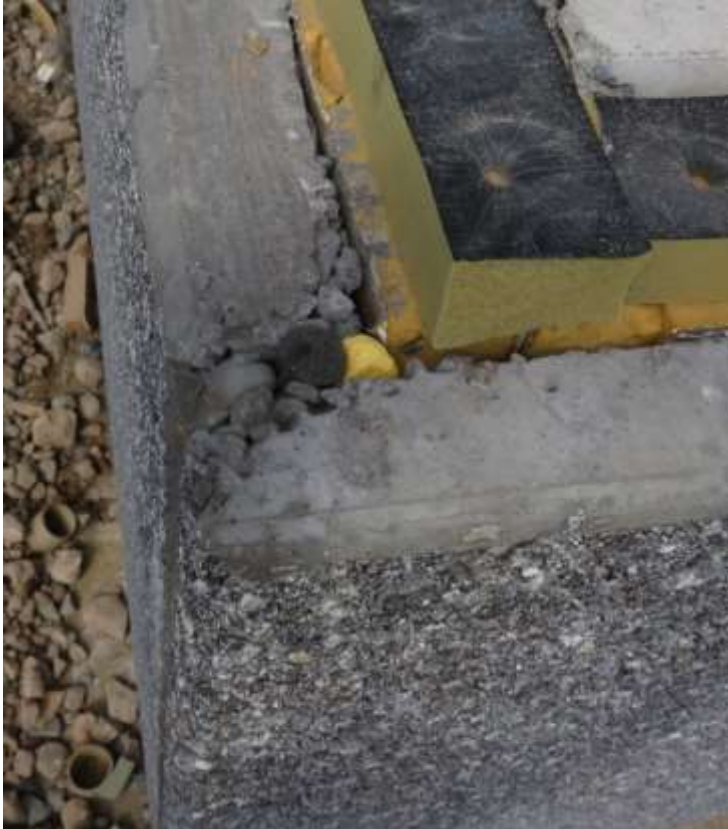
Figuur 58. Verticale voeg met kit, voegband en PU-schuim.
