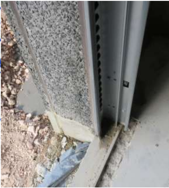
Figuur 64. Poort op binnenblad bevestigd.
