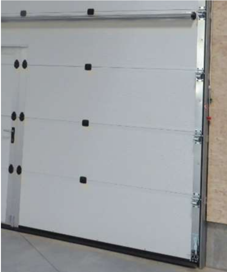
Figuur 108. Plaatsing poort op houtskeletwand.
