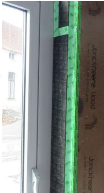
Figuur 107. Plaatsing via folie
