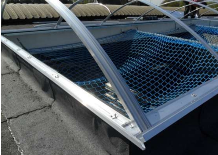
Figuur 46. Metaalconstructie voor lichtstraat. 23
