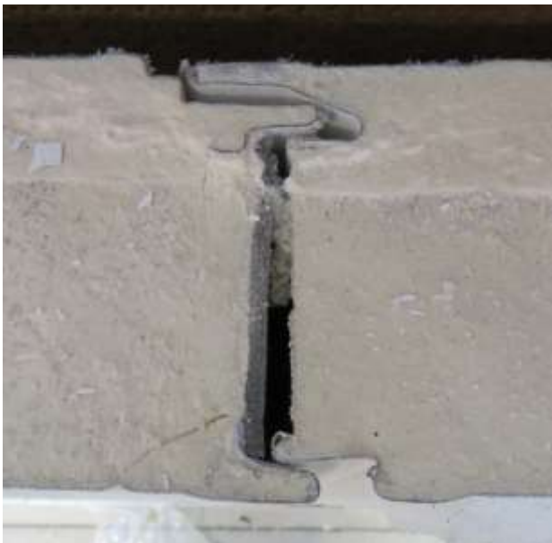
Afbeelding 9. Beperkt contact tussen sandwichpanelen.
