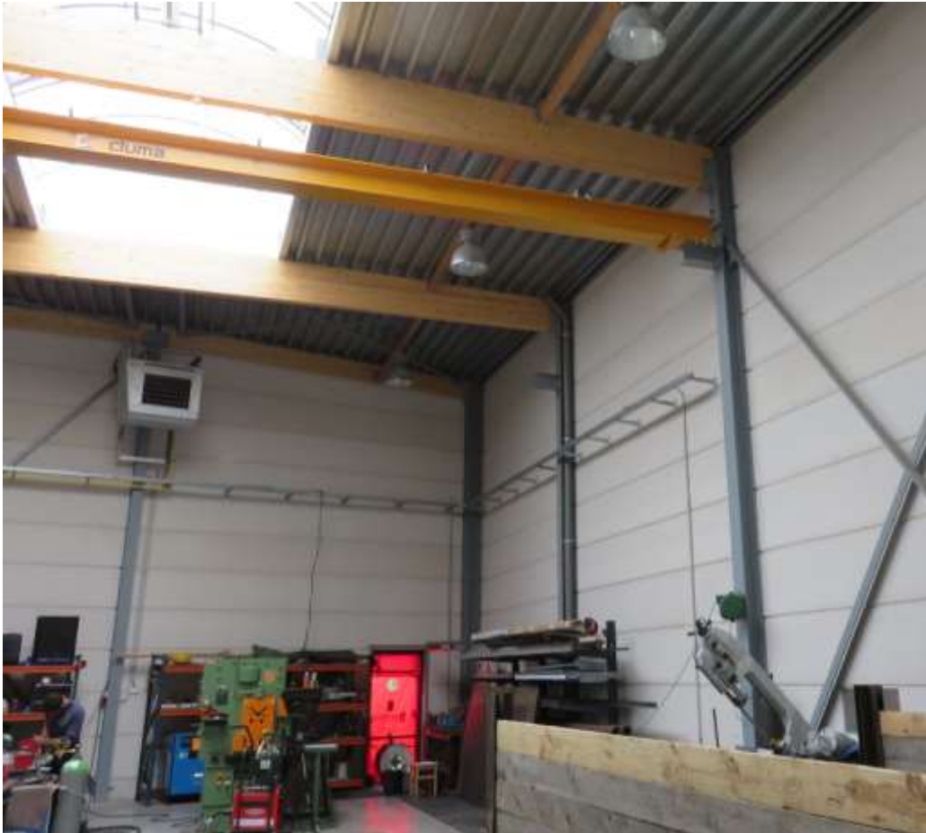
Afbeelding 11. KMO-unit opgebouwd met Hebel-panelen.
