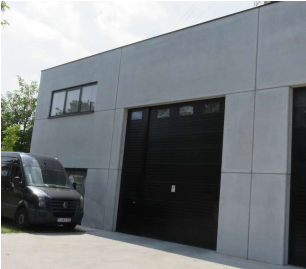
Afbeelding 20. Gebouw opgetrokken in beton sandwichpanelen.
