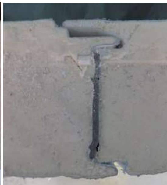
Afbeelding 10. Plaatsing volgens de regels van de kunst.
