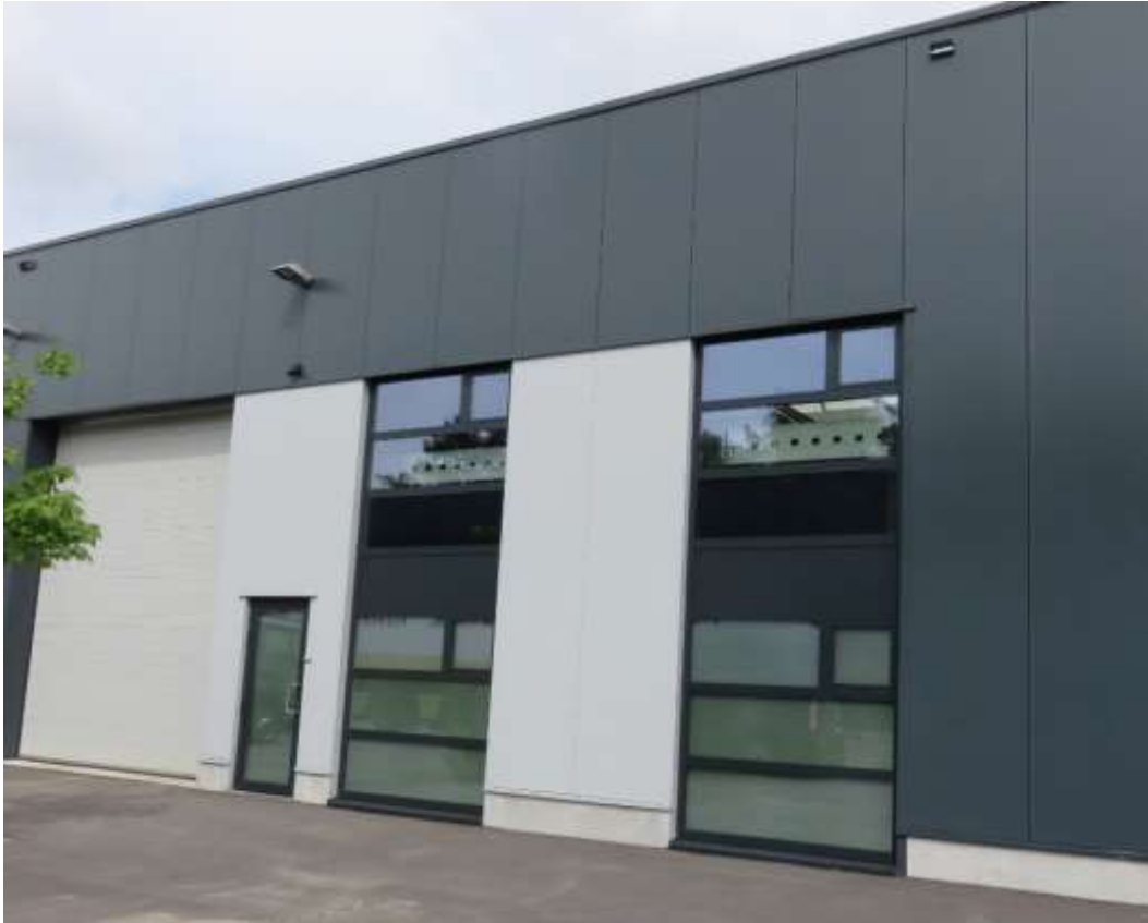
Afbeelding 18. Eén unit van het verzamelgebouw.
