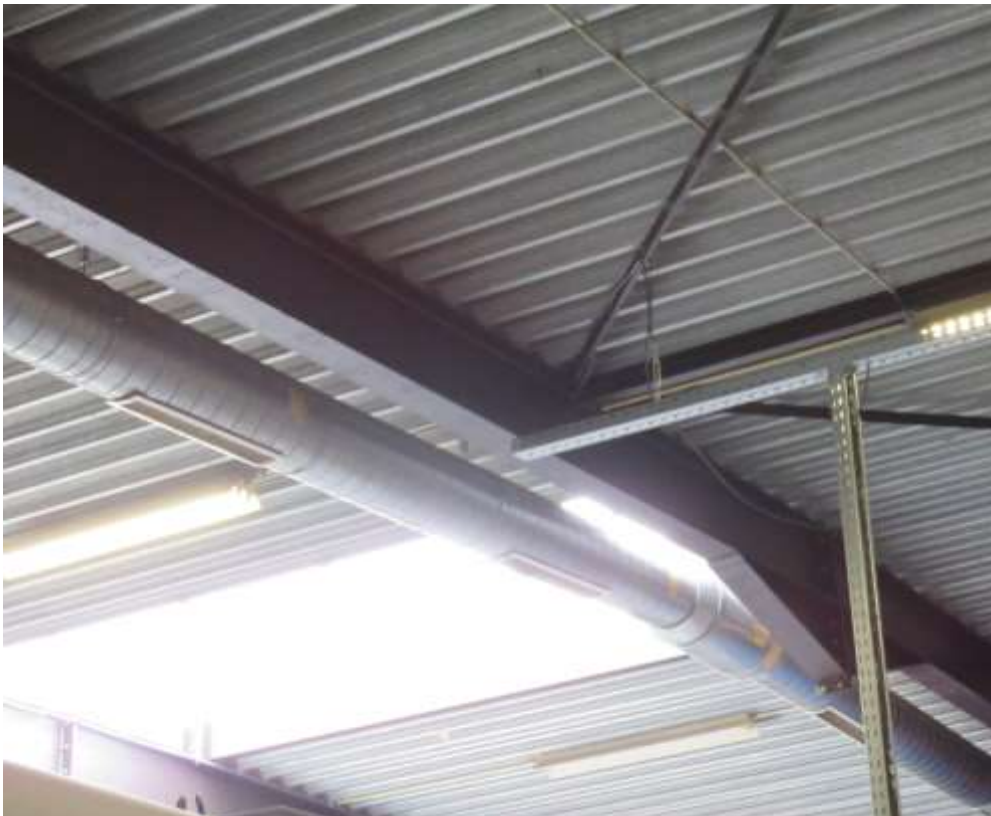
Afbeelding 17. Open ventilatiekanalen
