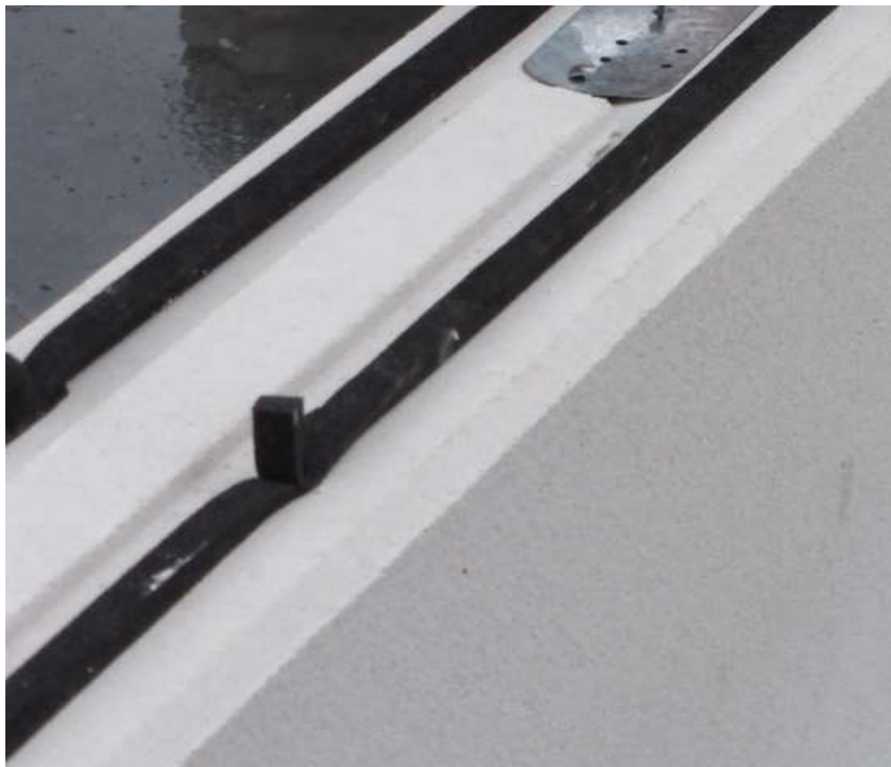
Afbeelding 12. Dubbele mousseband gebruikt bij plaatsing van Hebelpanelen.
