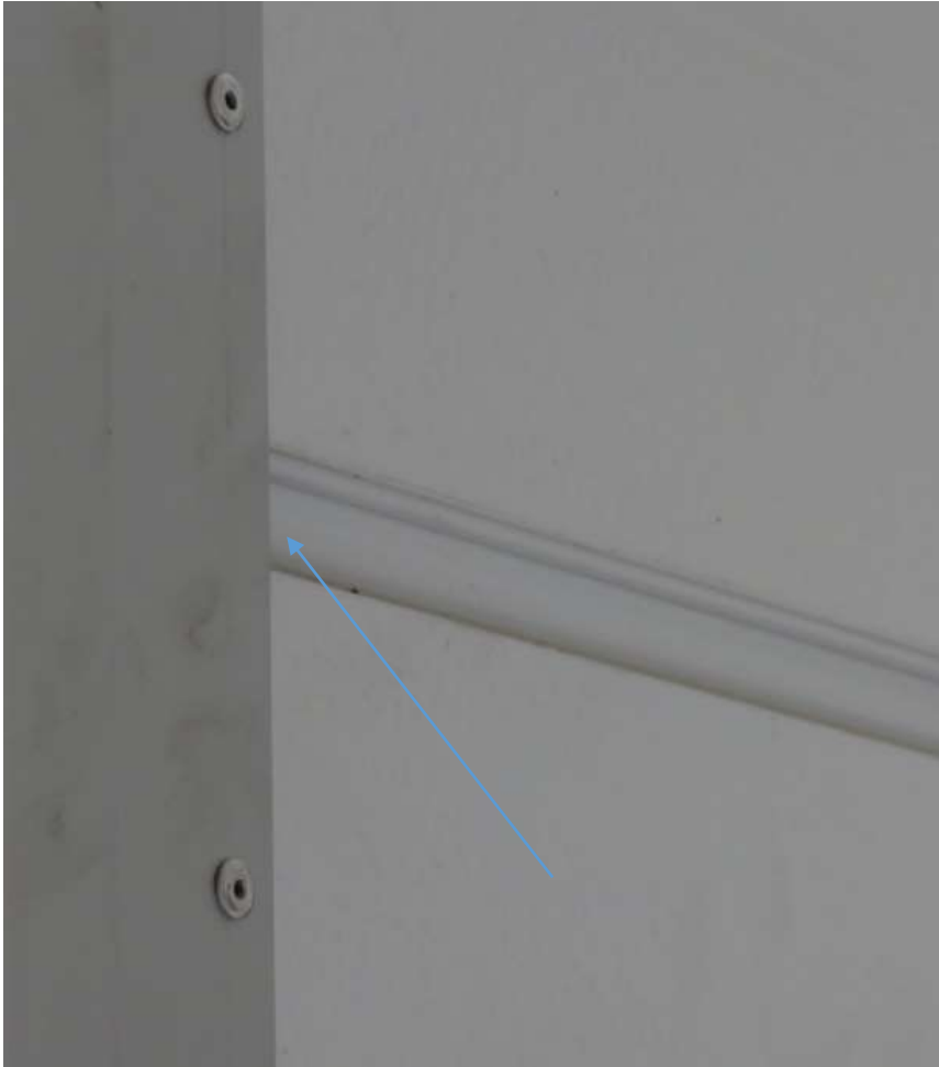
Afbeelding 21. Detail van profilering deurpaneel met aanduiding luchtlek
