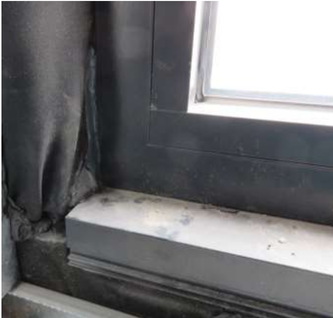
Afbeelding 8. Aansluiting van raam op sandwichpaneel en metaalstructuur.
