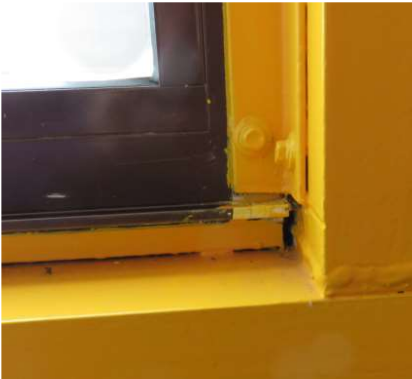
Afbeelding 15. Luchtlek ter hoogte van onderkant raamaanluiting .
